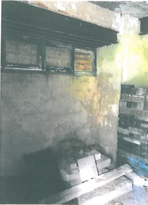
Bild 4: Abstellraum, talseitige Außenwand
