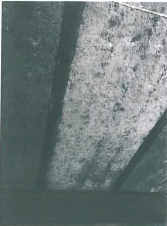
Bild 6: Decke aus Trägern und Schlackebeton
