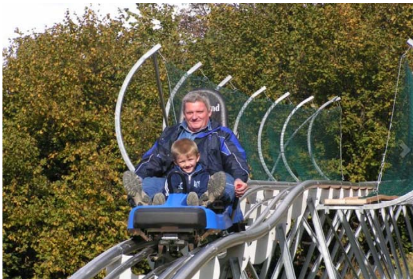
Abbildung 4: Alpine Coaster der Firma Wiegand (aufgeständert mit Sicherheitsnetz und seitlichen Stegen)
