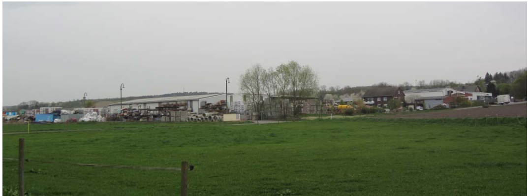
Abb.: Blick auf das vorhandene Gewerbegebiet (Baustoffhandel) aus Richtung Südosten
