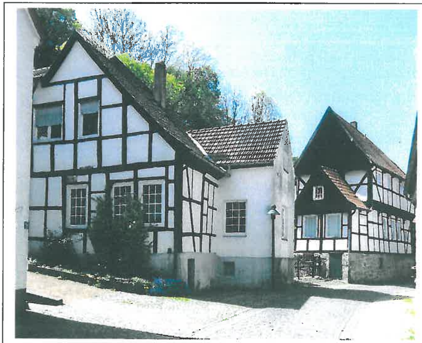
Tecklenburg, Ibbenbürener Straße 29 (vorne links) im städtebaulichen Zusammenhang mit den anschließenden Bauten Ibbenbürener Straße 33/35.
