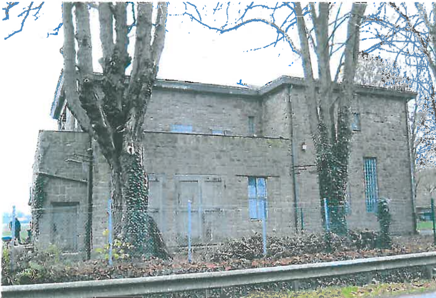
Abb. 1: Straßenansicht des ehemaligen Wasserwerks, Foto LWL-DLBW 11/2014
