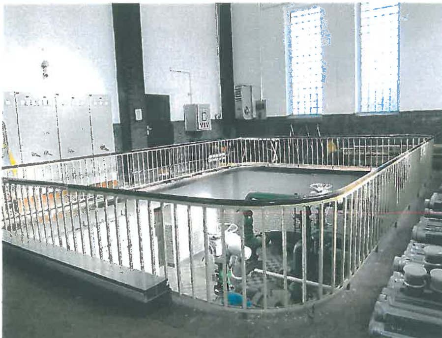
Abb. 2: Innenansicht des Pumpenraums, Foto LWL-DLBW 03/2015
