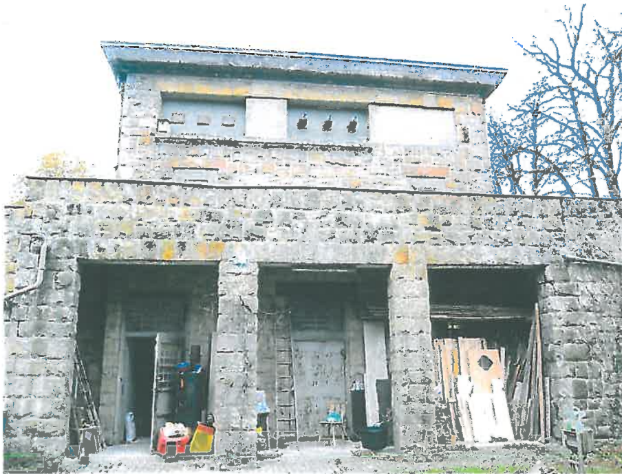
Abb. 3: Seitenansicht der Umspannstation mit Kolonnade, Foto LWL-DLBW 11/2014
